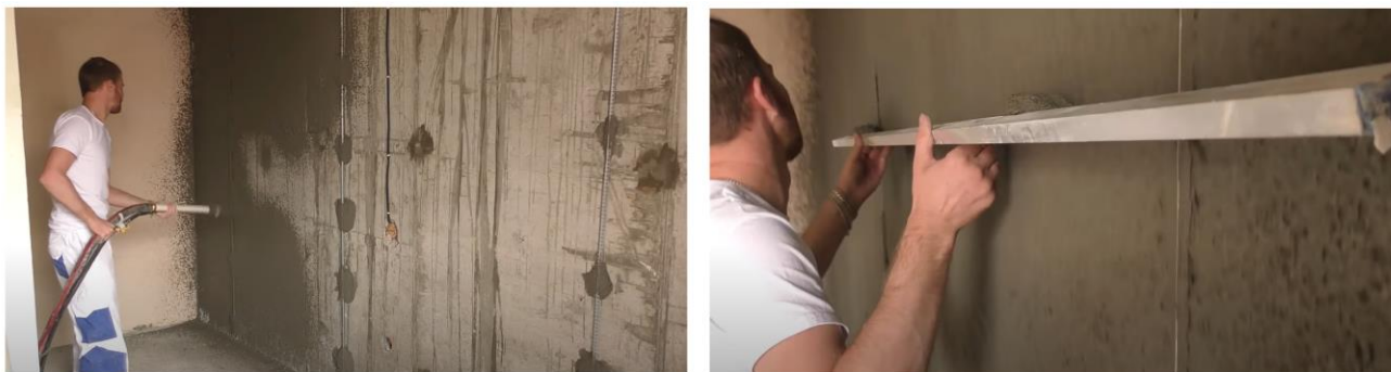
Рис. 28. Схема нанесения обрызга на поверхность и разравнивание правилами образовавшихся наплывов
