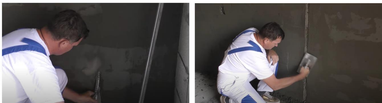
Рис. 30. Схема демонтажа маяков и заделки образовавшихся борозд
